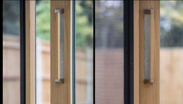
Schiebeflügel bündig mit Mittelpfosten
